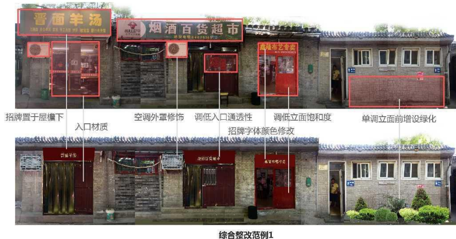
综合整改范例1
